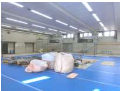
武道場内 エアコン設置工事
