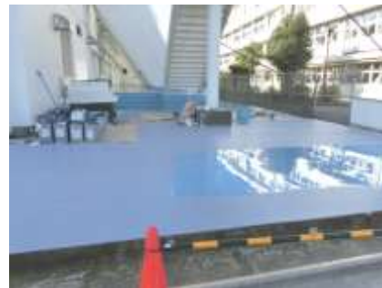
武道場・外側 床面塗装中
