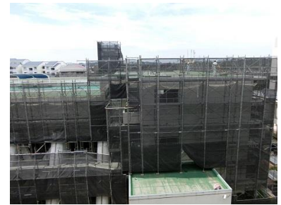
体育館棟 外壁工事中
