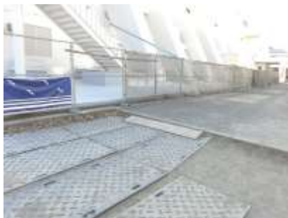
外壁工事 囲い等 撤去直前
