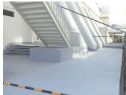
外壁工事ほぼ終了 コーティング された床面
