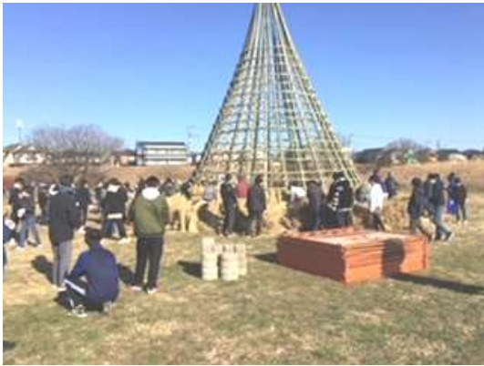
壁面のわらを敷き詰めるところ
